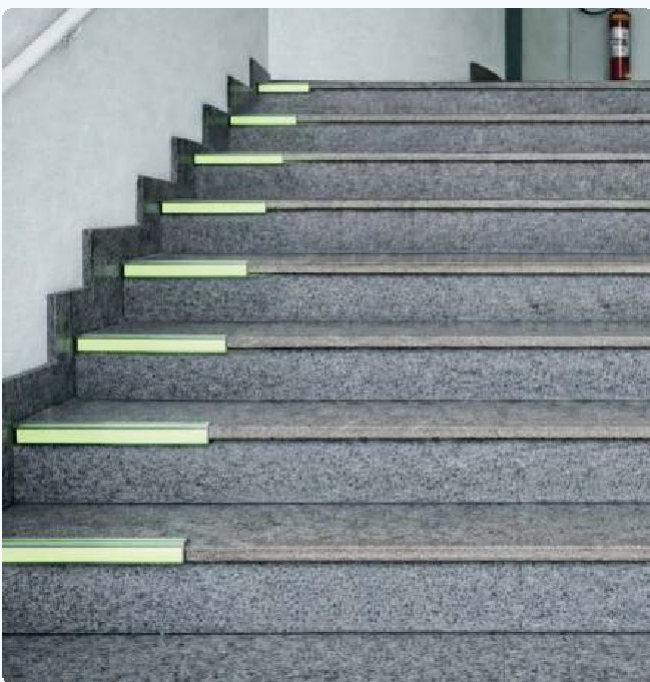
Item 24: Sinalização de Degraus
