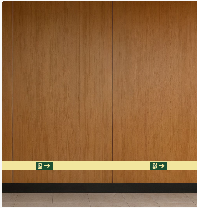
ITEM 6 Sinalização Adesiva Fotoluminescente de Rota de Fuga
