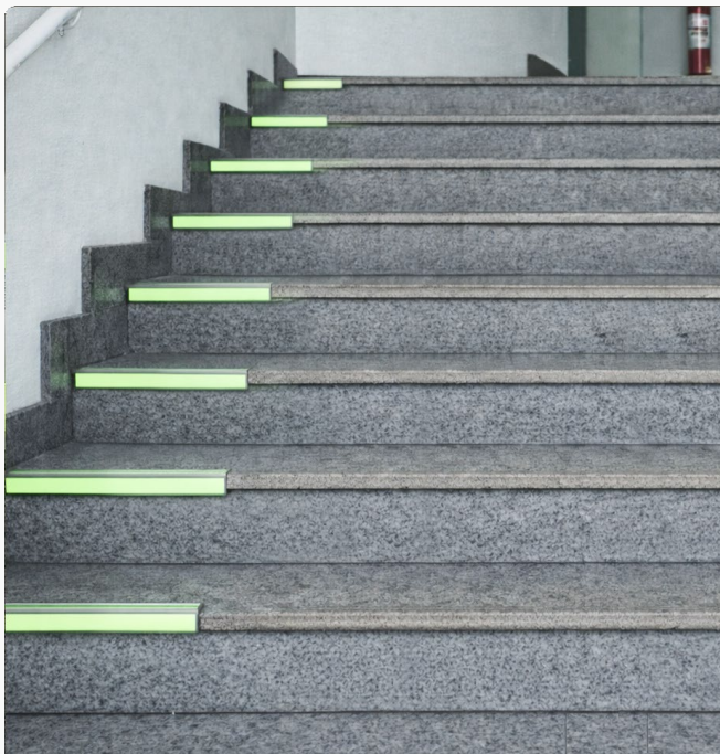
ITEM 16 Sinalização de Degraus
